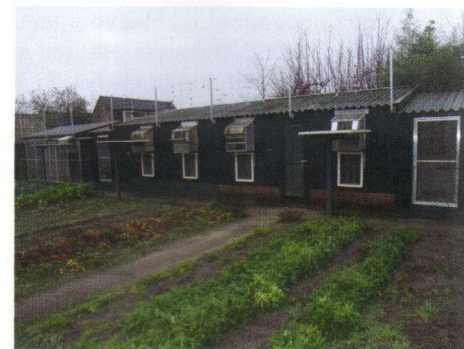
Hokinstallatie Freek Wagenaar
